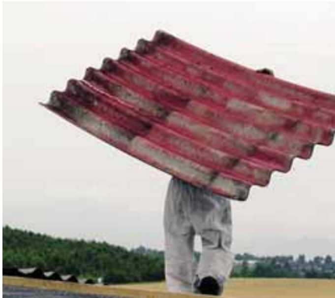
Lavori di bonifica dall'amianto: ad Almenno via al censimento
