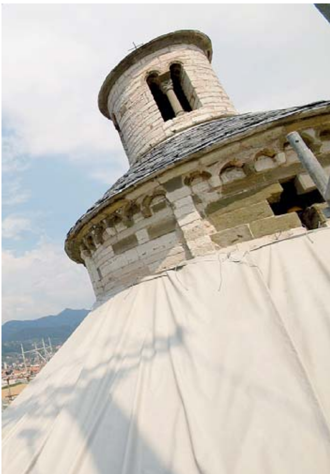
Domani visita al cantiere di San Tomè, ad Almenno San Bartolomeo
